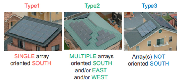
Fig. 48. PV module configuration [176].
